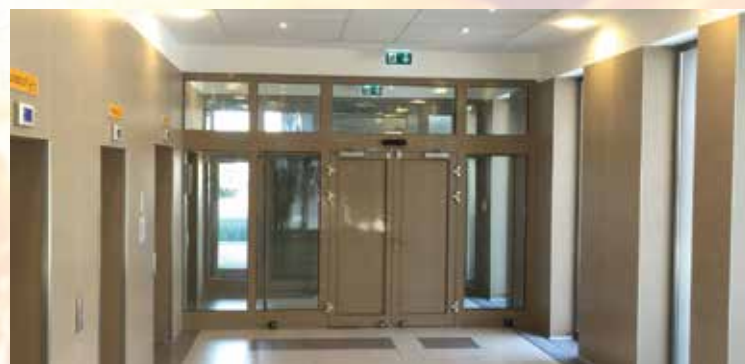
El60 tűzgátló üvegezett portálszerkezet alumínium profilos, teli betétes ajtóval – Fejér Megyei Szent György Kórház
